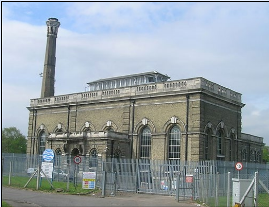
Viktorianische Pumpstation in London, England, die einst eine riesige Dampfpumpmaschine enthielt
