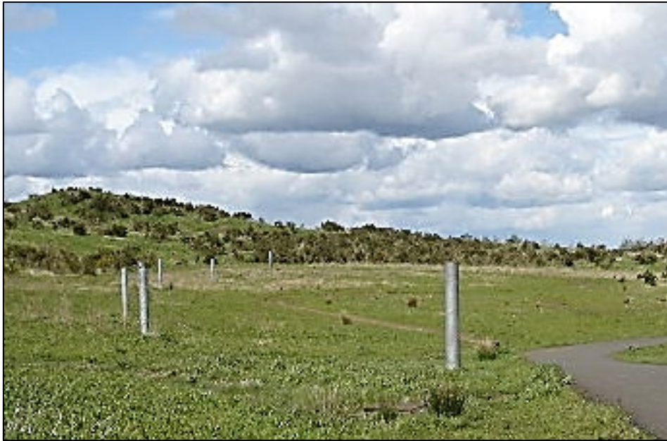
Abb. 6.11. Methangas-Entlüftungsöffnungen auf einer alten Landschaftsdeponie, auf der in der Vergangenheit Ölschiefer abgebaut wurde, Seafield, West Lothian, Schottland
