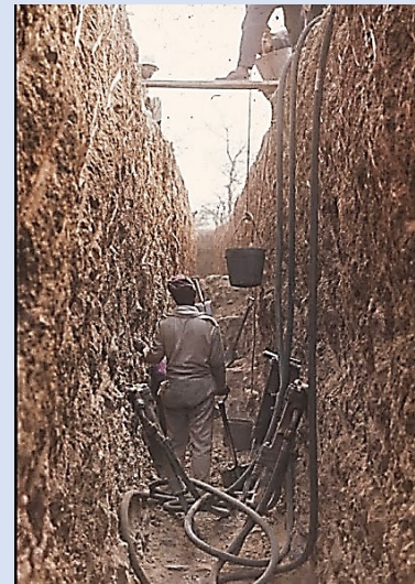
Ausheben von Gräben bis zum Gestein an der Basis (vor modernen Gesundheits- und Sicherheitsvorschriften)
