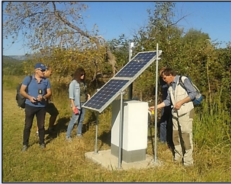
Aufzeichnungsausrüstung für eines einer Reihe von Seismometern, die in einem Loch in der Nähe des Golfs von Korinth, Griechenland, stationiert sind
