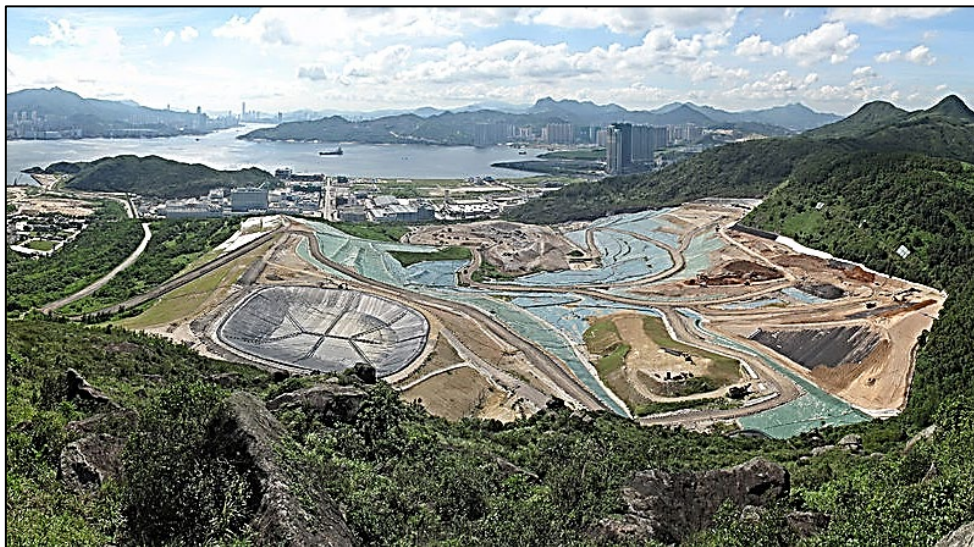
Abb. 6.10. Deponie der South East New Territories, Hongkong, ausgekleidet mit Geotextilmembran
