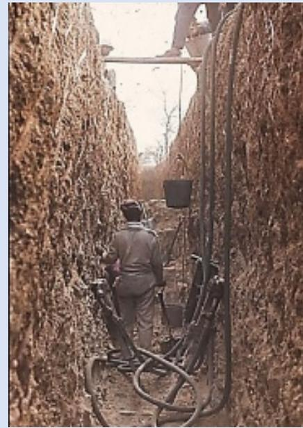
Excavation de tranchées jusqu'à la roche-mère (avant les réglementations modernes en matière de santé et de sécurité).
