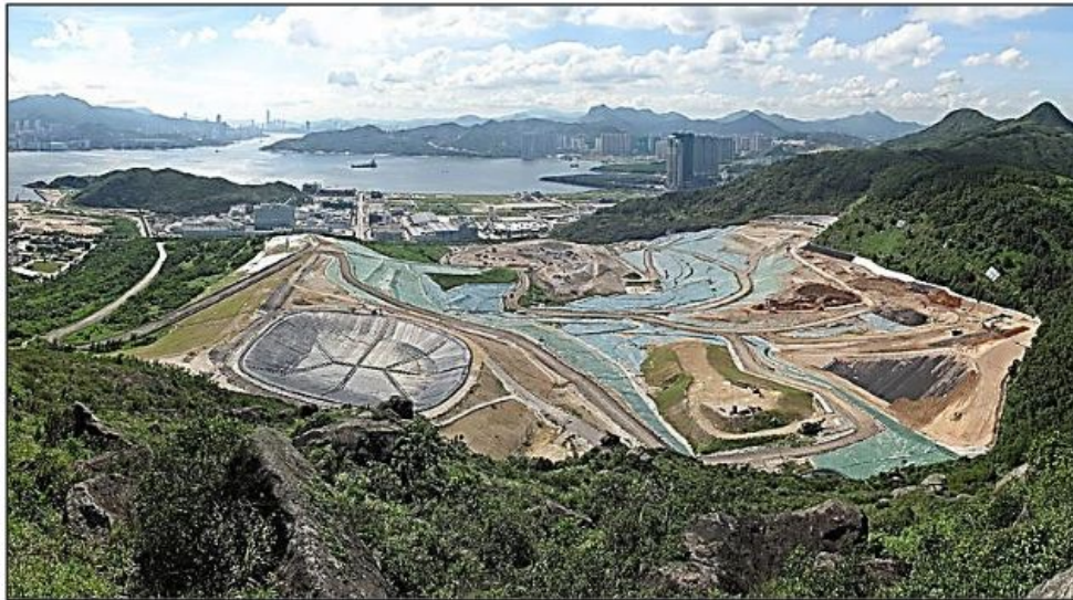
Figura 6.10. Aterro do Sudeste de Novos Territórios revestido com membrana de geotêxtil, Hong Kong.
