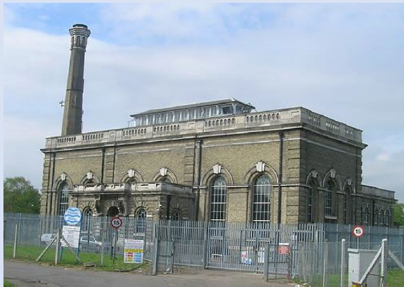
Estação de bombeamento vitoriana, Londres, Inglaterra, que continua utilizando um enorme motor de bombeamento a vapor.
