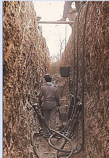
Escavando trincheiras no leito rochoso (antes dos regulamentos modernos de saúde e segurança)
