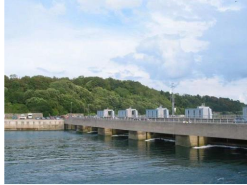
フランス、Bretagne の Rance の川河口にある潮力発電所のダム
