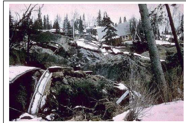
地滑りで流された建物 - Anchorage の Turnagain Heights landslide。1964年の地震（マグニチュード 9.2）により、土壌が液状化して 700m 移動した郊外では、75 棟が崩落し、ねじ曲がり、崩壊した。
